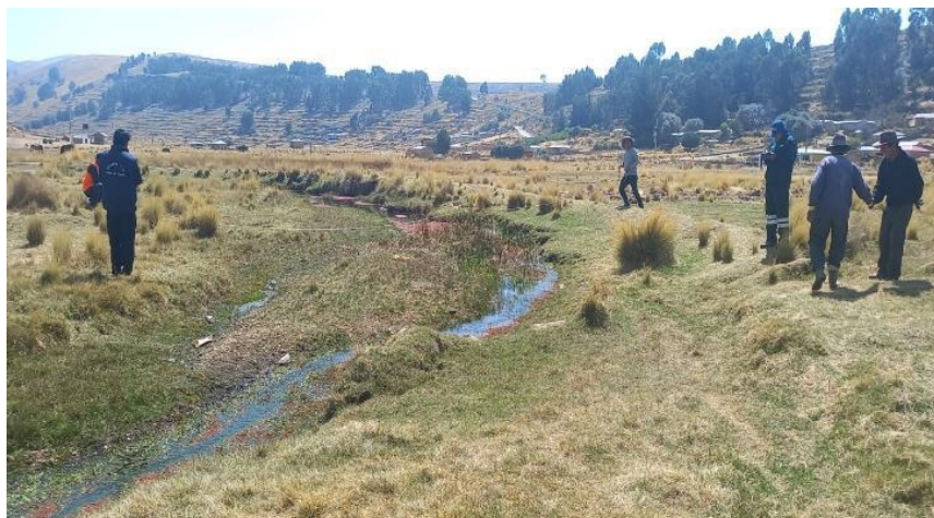
Fotografía 3. Dique margen derecho del cauce del rio Callacame, en estado critico, lo que permite el desborde en epocas de avenida afectando cultivos agricolas de los centros poblados Villa Aychuyo, Kehuaría Pajana, Villa Mar Aychayo y Pajana San Agustín, del distrito de Yunguyo.
