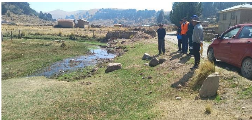
Fotografía 1. Cauce del rio Callacame colmatado con material de vegetacion que no permite el flujo de agua en epoca de avenida, asimismo desborde ene epocas de avenida a la margen izquierda del cauce, afectando carreteras, viviendas y cultivos agricolas
